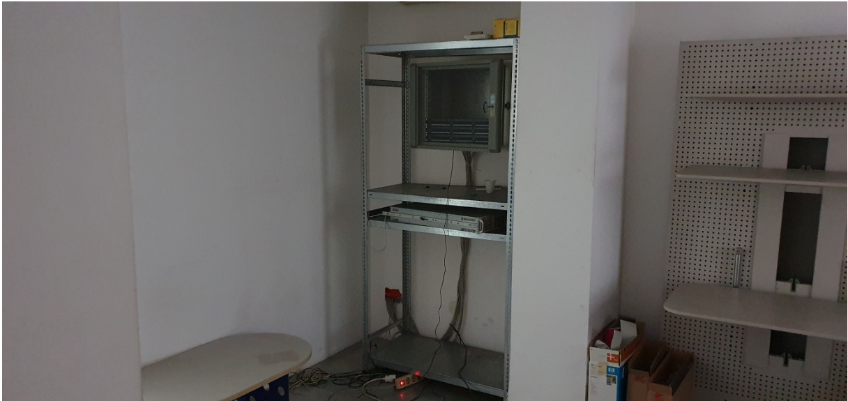
16 Mrežni ormar dimenzija 48x60x50 cm sa tri mrežna switcha model Enhanced C5
